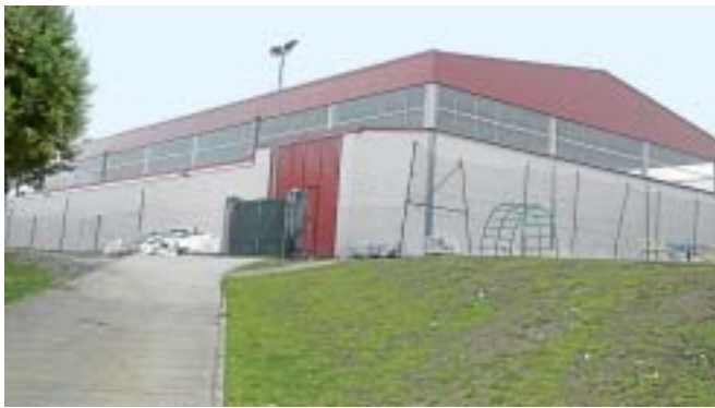
Nuevo pabellón municipal de Fuenteguinaldo. /CASAMAR
