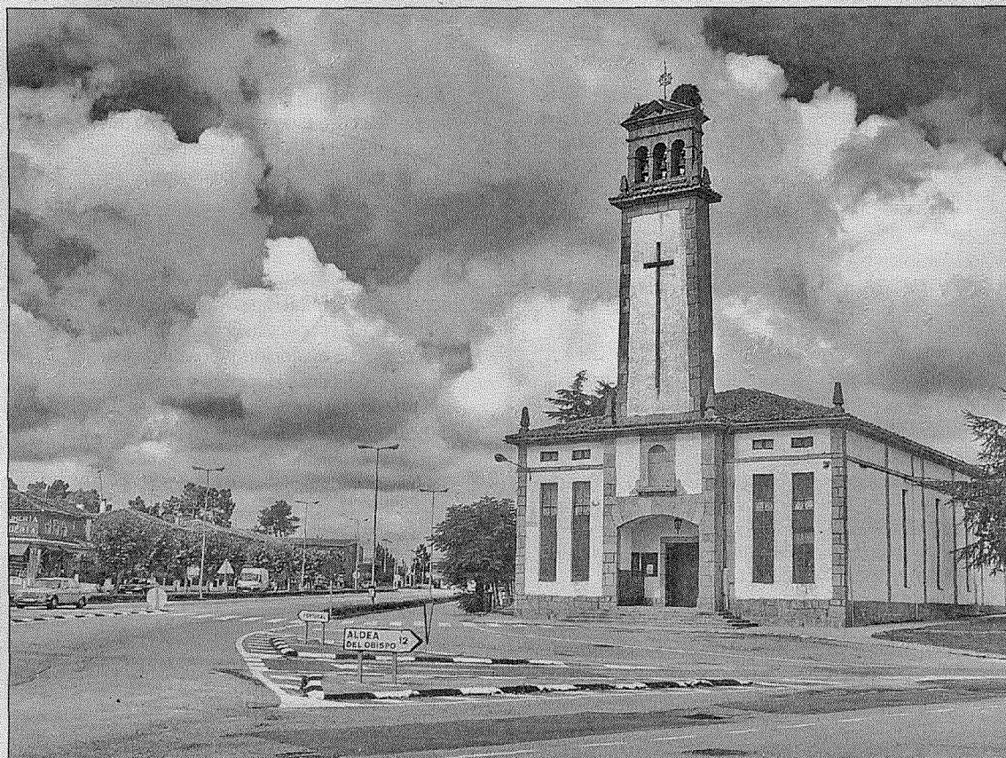
Vista parcial del nuevo poblado de Fuentes de Oñoro, en donde se encuentra centrada la actividad económica.
