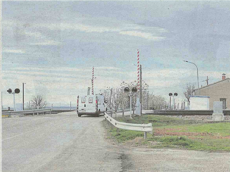
El paso a nivel situado a la entrada del casco urbano de Gomecello soporta una alta densidad de tráfico./EÑE
