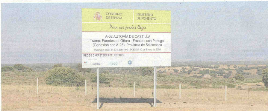
Un cartel anuncia la construcción del tramo de autovía que queda por finalizar de la A-62 en Fuentes de Oñoro. | CASAMAR
