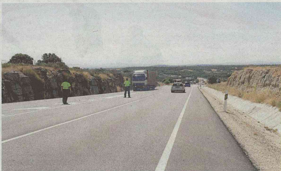
Tramo de la N-620 en Fuentes de Oñoro. I ARCHIVO
